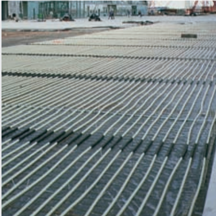
Панельное отопление промышленных помещений Roth
