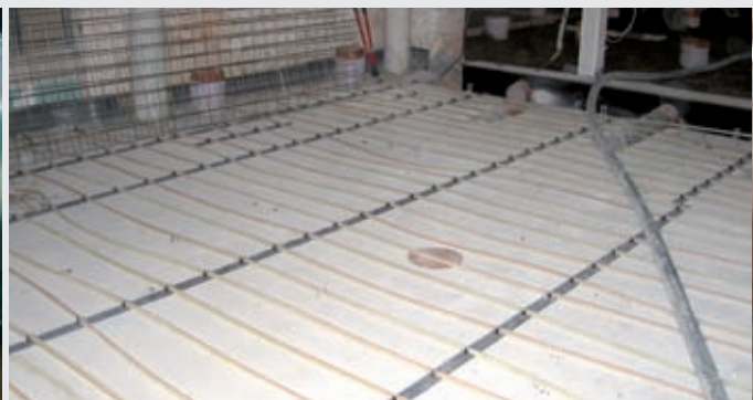
Система напольного отопления Roth, церковь св. Якова, Штральзунд, Германия
