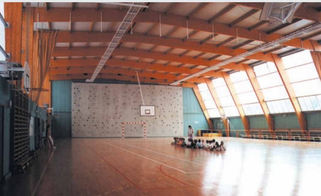
Система напольного отопления Roth, спортзал и фитнес-центр, Барбезье, Франция
