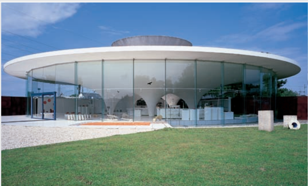
Система панельного отопления Roth, музей керамики Keramion.
