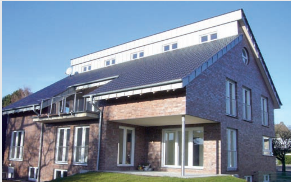
Система напольного отопления Roth (система Roth Original-Tacker с X-PERT S5+ 17 мм), Тепловой насос Roth TerraCompact E x 17 кВт и накопители хозяйственно-питьевой воды Roth DUO 500, Частный односемейный дом, Ор-Эркеншвик, Германия
