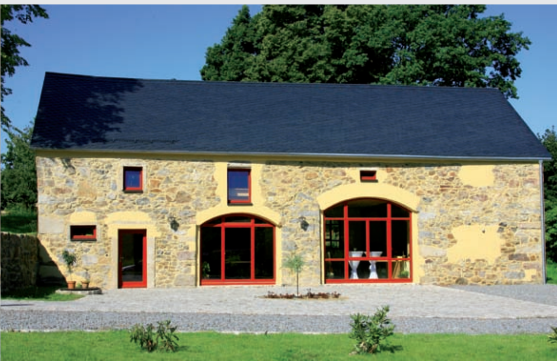
Система Roth Original-Tacker и тепловой насос Roth AuraCompact E x 12 кВт E, бизнес-центр и центр обучения, Арнсдорф, Германия
