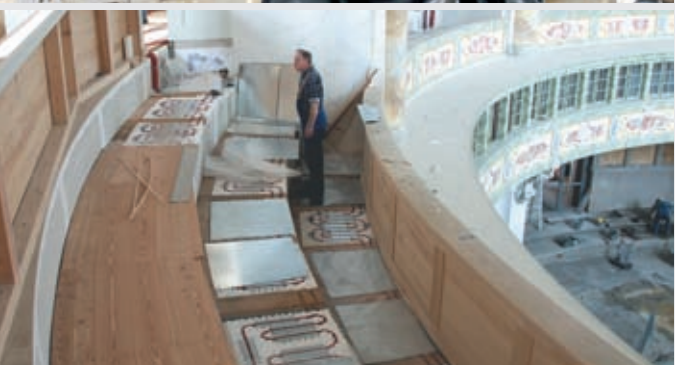
Система панельного отопления Roth, Фрауенкирхе, Дрезден, Германия
