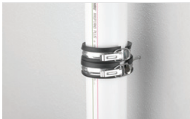
Рис. 7-3 Шумопоглощающий хомут в смонтированном состоянии
