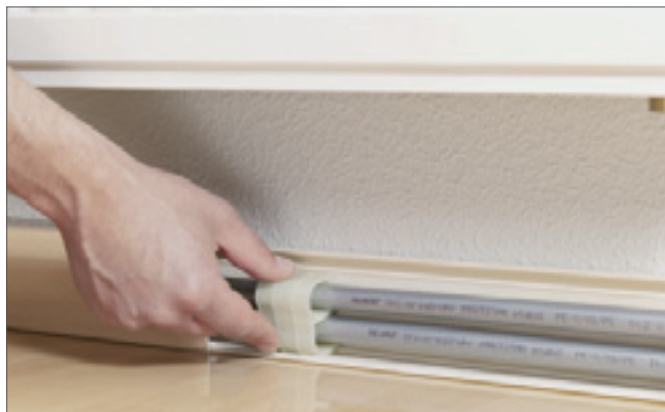
Рис. 18-37 Установка фиксаторов труб отопительной разводки
