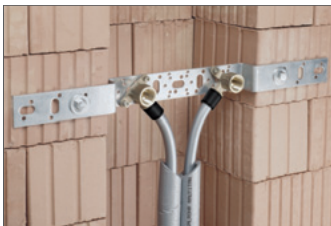
Рис. 6-5 Пример монтажа длинного кронштейна 75/150
