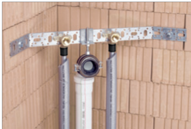
Рис. 6-4 Пример монтажа кронштейна
