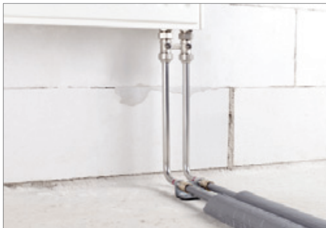
Рис. 4-12 Подключение к радиатору из пола
