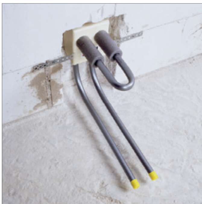
Рис. 4-13 Подключение к радиатору из стены
