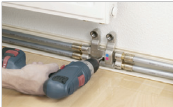
Рис. 18-36 Закрепление крестовины SL-RAUTITAN
