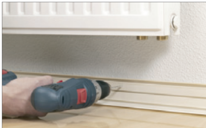
Рис. 18-31 Закрепление основания плинтусного канала RAUSOLO
