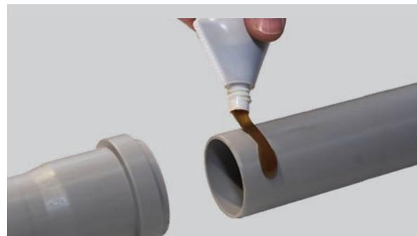
При вставке трубы на уплотнительном кольце не должно быть смазки. Выровняйте по центру вставляемый конец трубы и до упора задвиньте в раstrуб.
