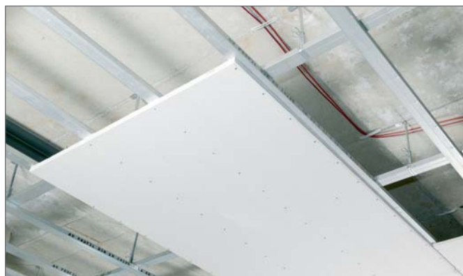
Рис. 3-05 Смонтированный потолочный элемент
