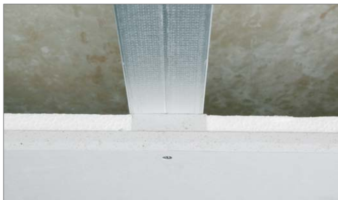
Рис. 3-06 Крепление потолочных панелей
