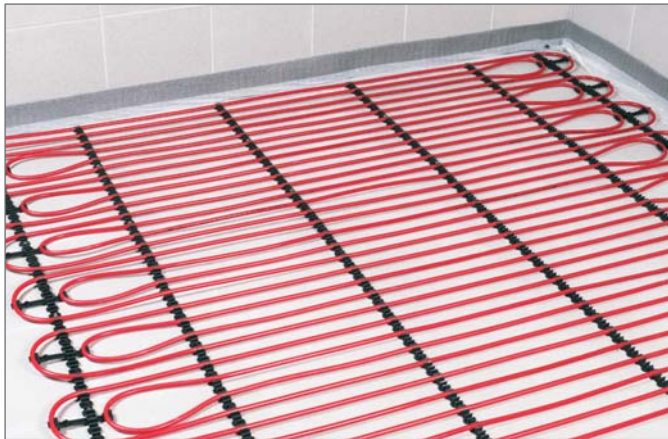
Рис. 2-01 Напольная фиксирующая шина для «мокрого» способа монтажа
