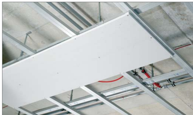
Рис. 4-05 Стеновая панель обогрева и охлаждения, смонтированная на потолке
