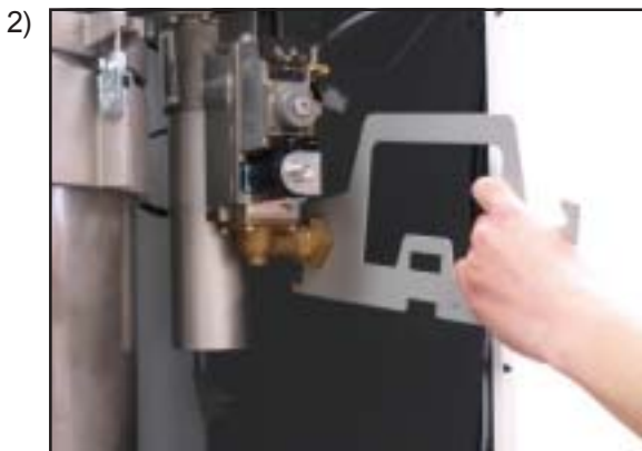
2) Осоединить подключение газа к комбинированному газовому клапану
