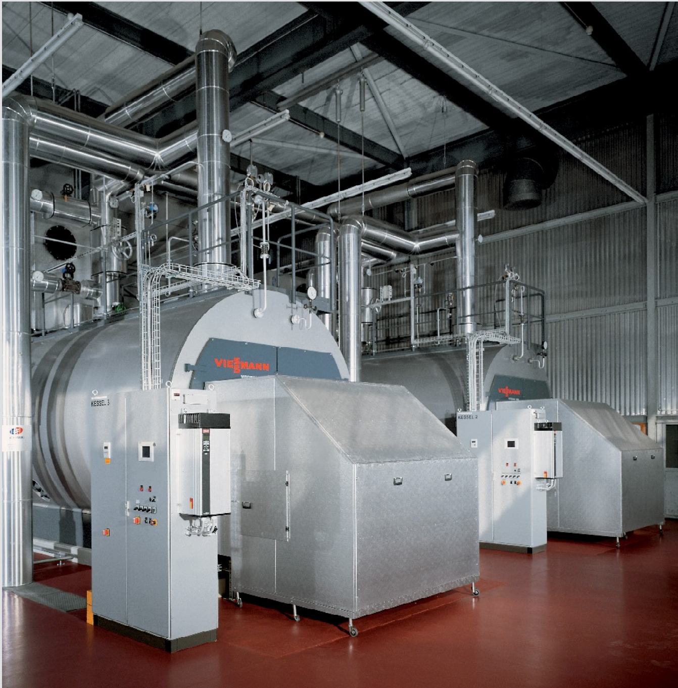
Водогрейный котел Vitomax 200-HW. Работа котлов в каскаде.
