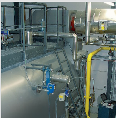
Паровой котел Vitomax 200-HS, тип M235 с интегрированным экономайзером.
