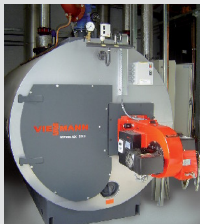
Паровой котел трехходовой конструкции Vitomax 200-LS в эксплуатации.
