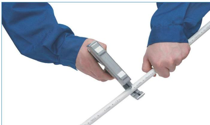
1. Отрезать требуемый кусок трубы перпендикулярно ее оси ножницами для многослойных труб или роликовым труборезом.
