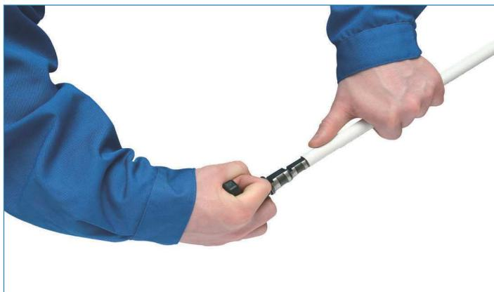
3. Раскалибровать трубу и снять фаску с ее внутреннего края калибратором. Слой алюминия не должен быть нарушен. Края трубы должны быть ровными и без заусениц.
