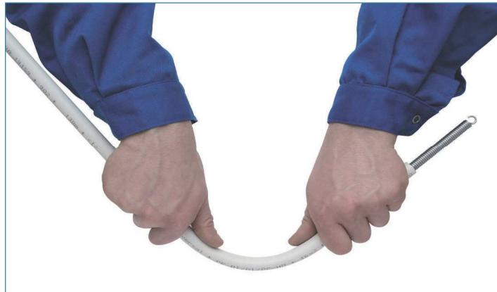
2. Придать трубе требуемую форму. Изгибать трубу с помощью наружной или внутренней пружины. Придерживаться минимального радиуса изгиба  $R > 5 D_{\text{нар}}$ . При использовании ручного трубогиба для труб диаметра 14 - 20 мм радиус изгиба  $R > 3,5$ . Первый изгиб можно делать на расстоянии не менее  $10 \times D_{\text{нар}}$  от места соединения.
