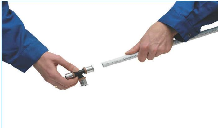
3. Трубу насадить на штуцер соединителя до упора. Проверить глубину вставки – край трубы должен быть виден через контрольные отверстия пластмассового дистанционного кольца.
