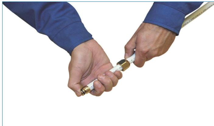
4. Надеть на трубу обжимную гайку. Вставить штуцер корпуса соединителя в трубу (до явного упора). Глубина вставки составляет около 9 мм для труб с диаметрами 14, 16, 20, а также 12 мм для труб с Ø25 (26) мм.
