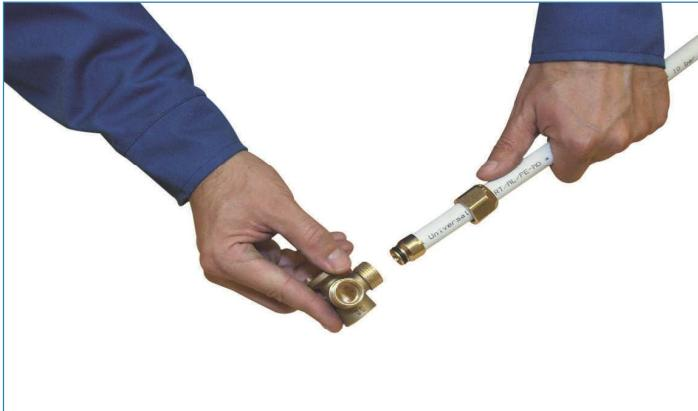
5. Корпус соединителя вставить вместе с трубой в гнездо фитинга (до явного упора).
