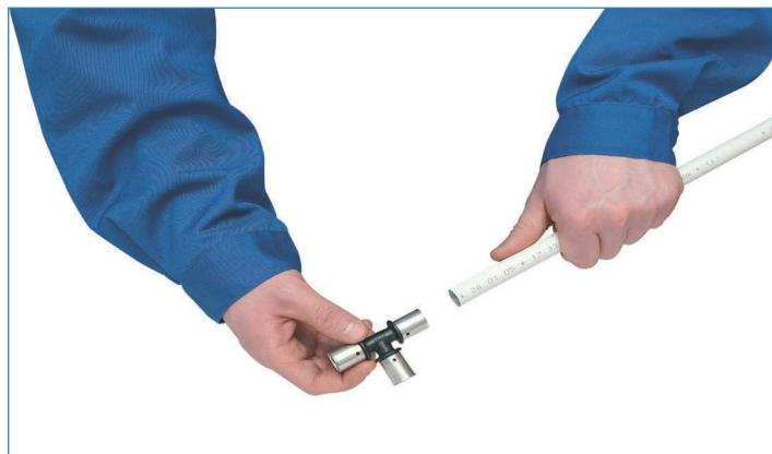
4. Трубу насадить на штуцер соединителя до упора. Проверить глубину вставки – труба должна быть видна через контрольные отверстия.
