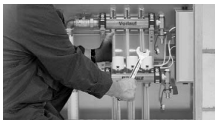
Коллектор Roth с индикатором потока
