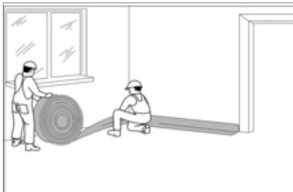
Рис.20. Раскладка под стеной краевой ленты.
